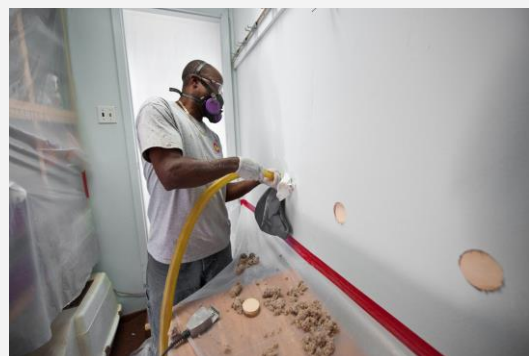
Figura 1 – Processo de isolamento de celulose nas paredes internas de uma casa
