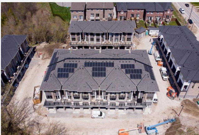
Figura 5 – Instalação dos painéis solares da microrrede de Pickering
