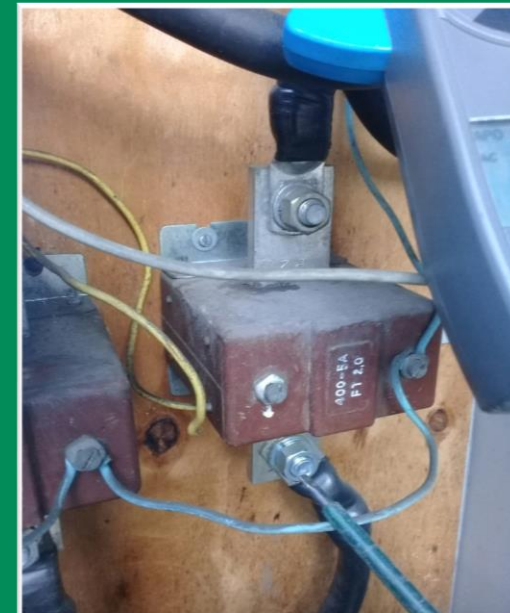
Manipulação de transformadores de corrente Identificada na Enel SP
