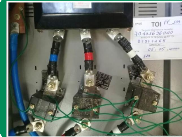
Manipulação de transformadores de corrente Identificada na Enel SP
