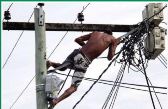
Furto de energia Identificado na Enel RJ
