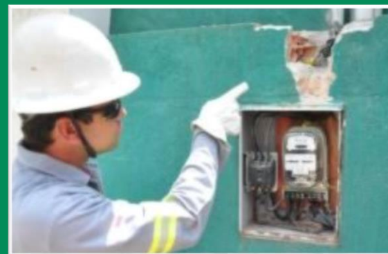
Bypass em medidor de energia Identificado na Enel CE
